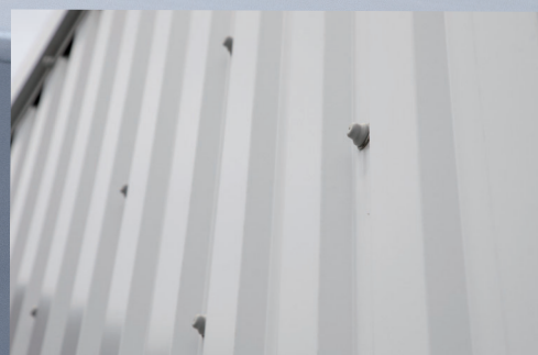
倉庫外壁 ガルバリウム鋼板縦張り
