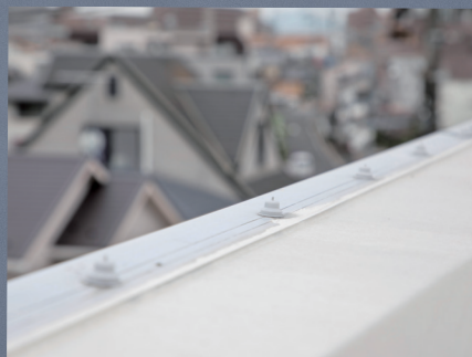
屋上防水 端部押さえ
