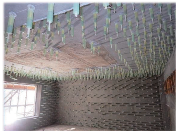
写真2 : LOG 注入状況
