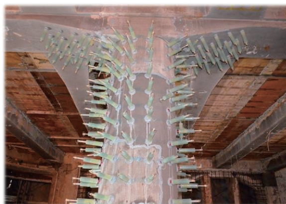
写真7 : 被爆建物・注入状況
