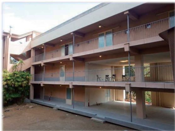
写真1 : LOG中庭からの外観
