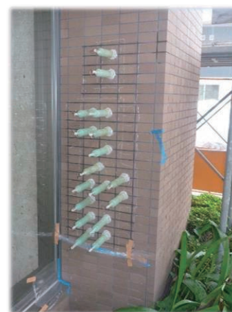
写真3 : タイル注入状況
